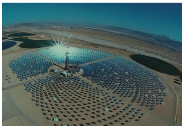
Das Sonnenkraftwerk „Solar 1“ in Daguerre, USA. Foto: AG
